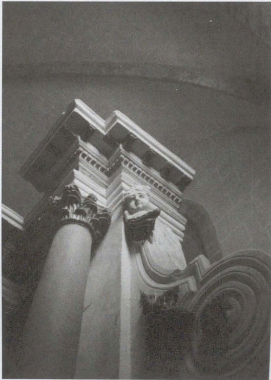
Brouy, église Saint-Pierre et Saint-Paul, retable en maçonnerie XVIII e siècle.
